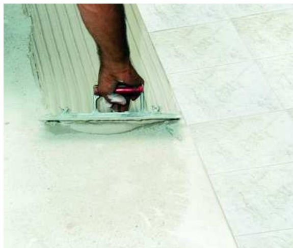
PCI® Carrament пластичный, удобный в применении раствор для укладки плит средним слоем.
