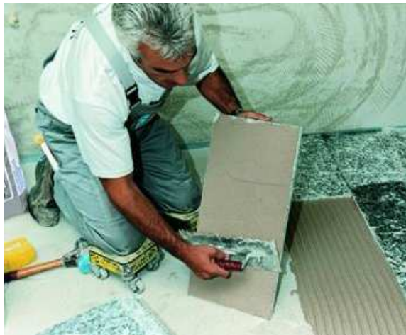
Для беспустотной укладки всегда наносите необходимый слой клея на обратную сторону плиты.
